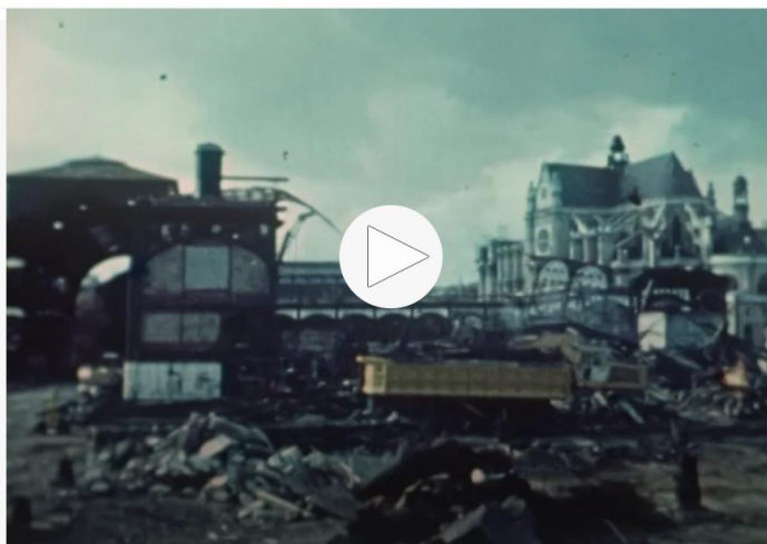
Démolition des Pavillons Baltard aux Halles - 1971 - 03:03 - vidéo
